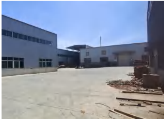
厂内项目南侧
