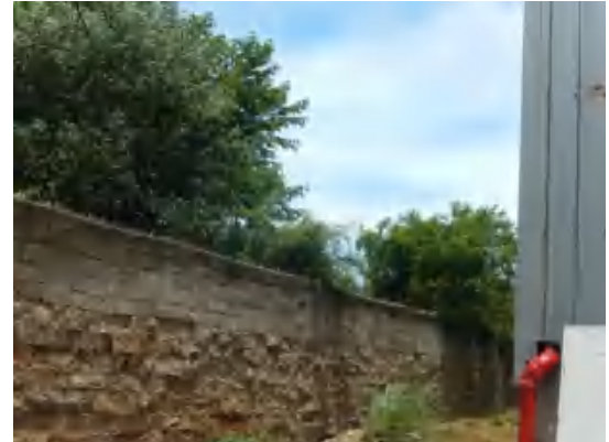
厂内项目北侧
