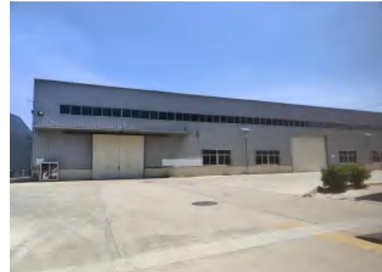
厂内项目西侧
