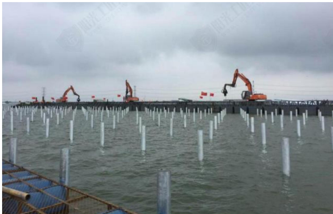
图 3.3-3 集装箱浮箱施工作业现场作业示意图
