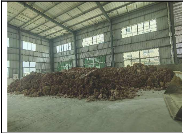
原料堆放现状 1
