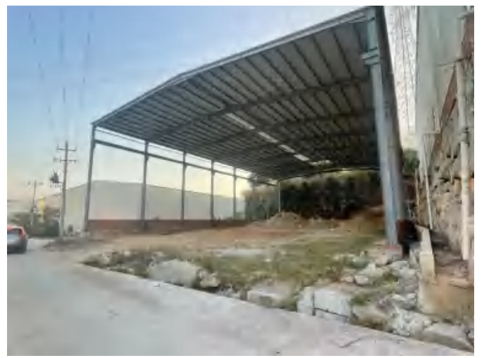
项目南侧：空置厂房
