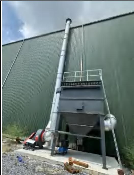
破碎、筛分粉尘废气排气筒 (DA001)
